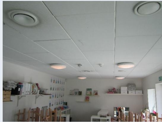
Figur 11. Typisk nyt belysningsanlæg med dagslysstyring
