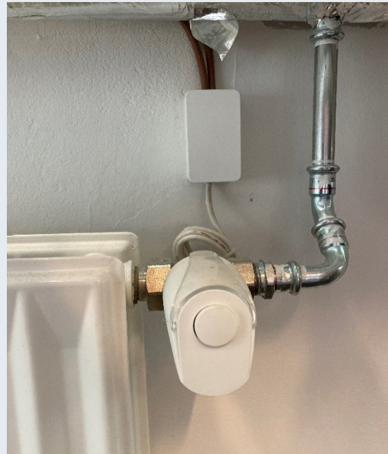
Figur 23. Typisk fjernbetjent radiatortermostatventil for bygningstypen.
