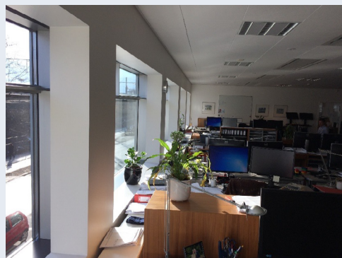
Figur 34. Typisk belysningsanlæg med dagslysstyring for bygningstypen (lyskilderne er slukket tæt på vinduerne).
