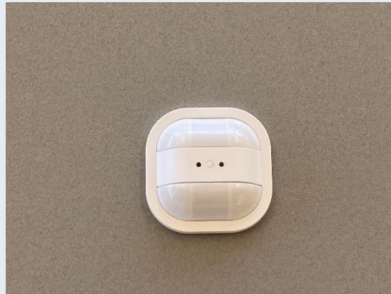
Figur 41. Typisk dagslyssensor for bygningstypen.
