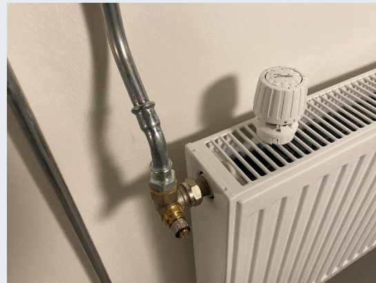
Figur 36. Typisk forindstillelig termostatventil for bygningstypen.
