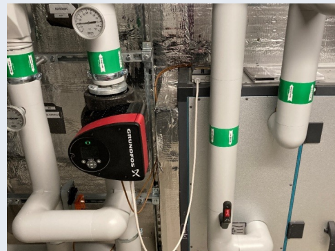
Figur 39. Typisk omdrejningsregulerbar cirkulationspumpe for bygningstypen.
