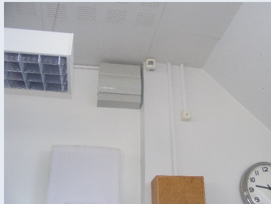
Figur 26. Typiske bevægelsesmelder/PIR-føler for bygningstypen.
