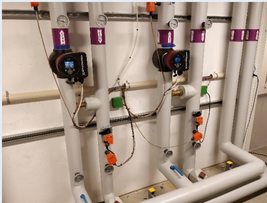
Figur 35. Typiske blandekredse med omdrejningstalsregulerbare cirkulationspumper for bygningstypen.
